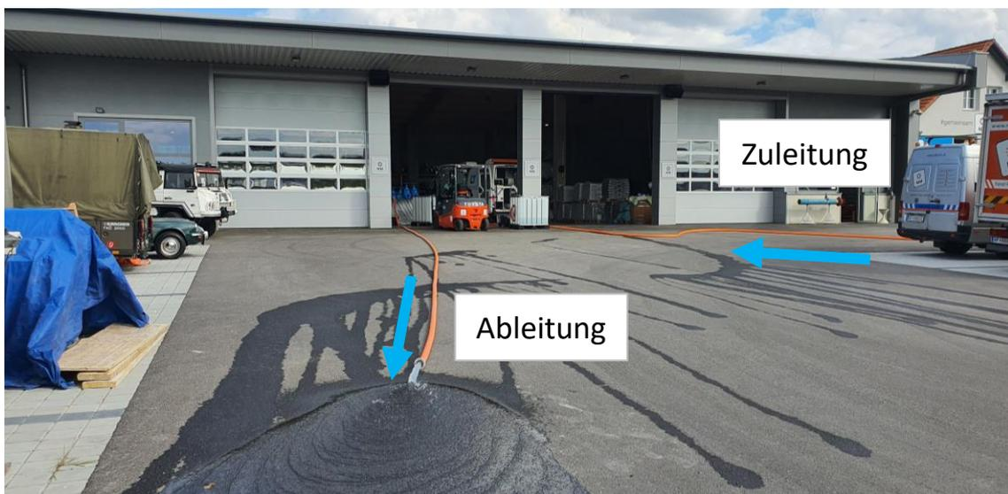
Abbildung 5-7: Freier Auslauf der Rohrableitung (Foto: Gruber, mod.).
