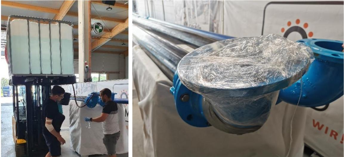
Abbildung 6-5: Befüllung der Leitungen (linkes Foto), die verschlossene Leitung 4 (rechtes Foto) (Fotos: Gruber).
