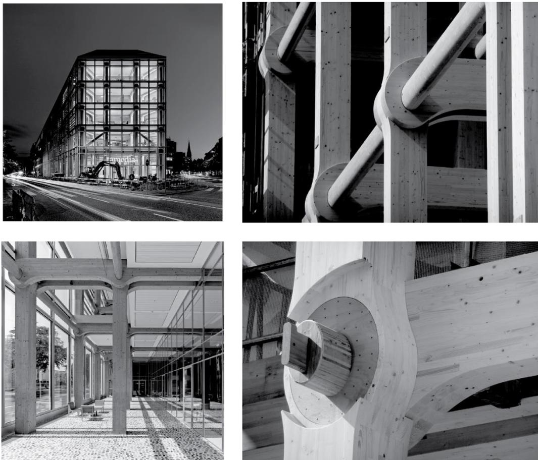
Abb. 28: *Tamedia Haus in Zürich, Beispiel eines Bauwerks mit angewandten bionischen Verbindungen (aasarchitecture.com, 5/2014)*
