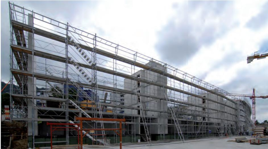
**Abb. 3.1:** Viergeschossiges Wohngebäude in Holz-Stahlbetonverbundbauweise in der Überbauung Grünmatt in Zürich.
