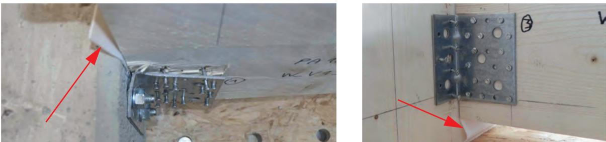
Abb. 3.8: Zwischen dem ‚Deckenelement‘ und dem ‚Wandelement‘ eingelegter Teflonstreifen
