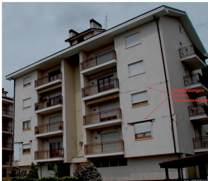
Abb. 2.22: Bild eines Wohngebäudes mit Verbundversagen in den Deckenanschlussfugen in L'Aquila, Italien (Quelle: Univ.-Prof. Dr. Scott Kieffer)
