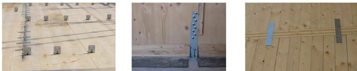
Abb. 5.2: Übliche Verbindungen bei normalen BSP-Gebäuden bis 3 oder 4 Geschosse
