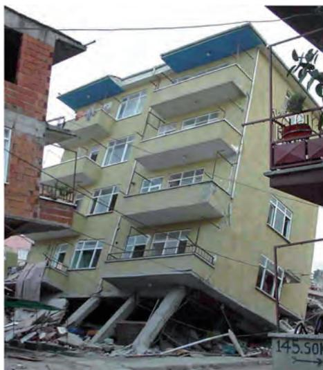
**Abb. 2.20:** „Soft-Storey-Failure“ eines mehrgeschossigen Wohnhauses in Golcuk, Türkei [16]
