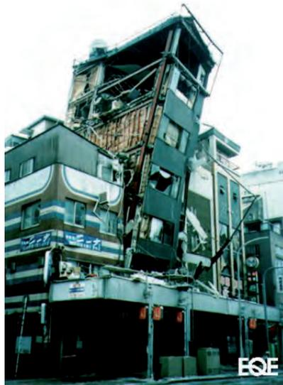
*Abb. 2.23: Gebäudeversagen zufolge Unregelmäßigkeiten im Aufriss, Kobe (Japan), [18]*
