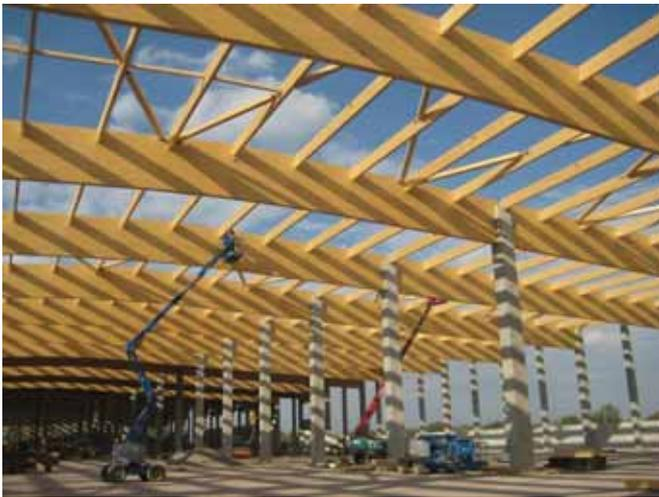
Abb. 2-16: Dachaufsteifung Brasov
