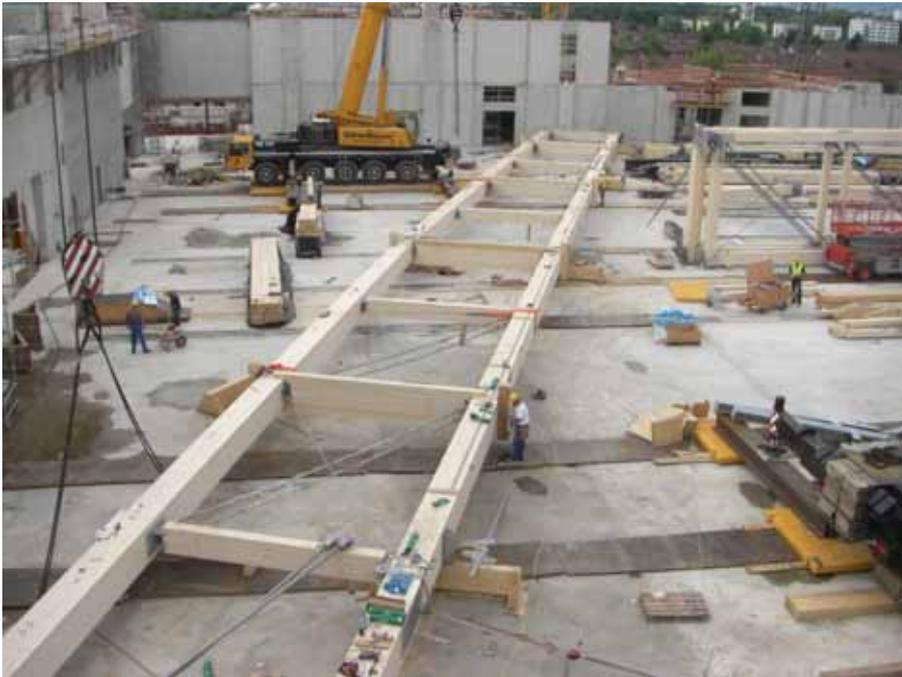
Abb. 2-11: Zusammenbau des Binders auf der Zwischendecke
