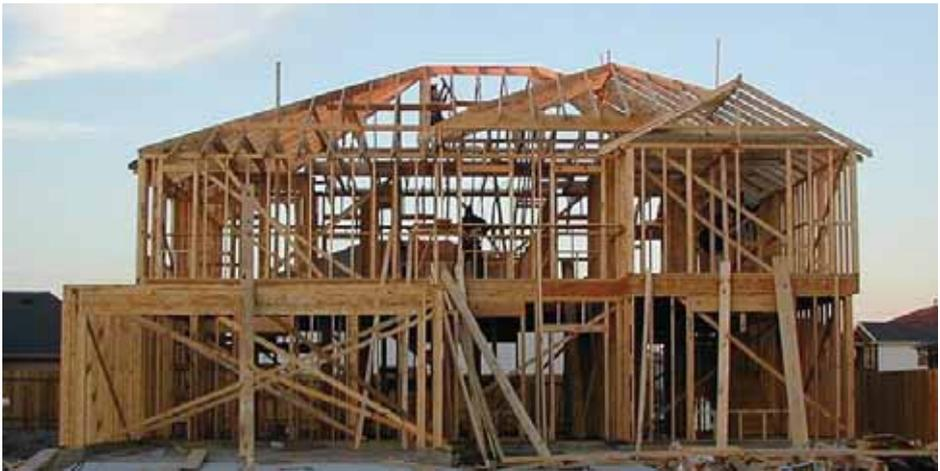
Abb. 12: typische amerikanische Holzleichtbauweise – Beispiel eines zweigeschossigen Wohnhauses während der Errichtung
