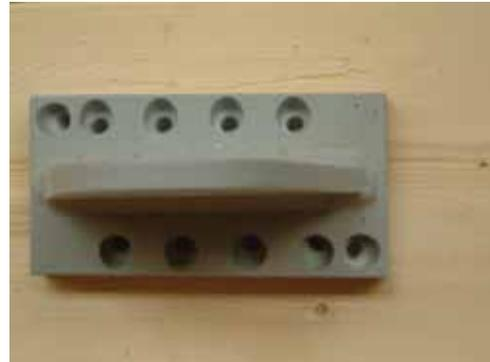
Abb. 2-13: Anordnung der Schrauben
