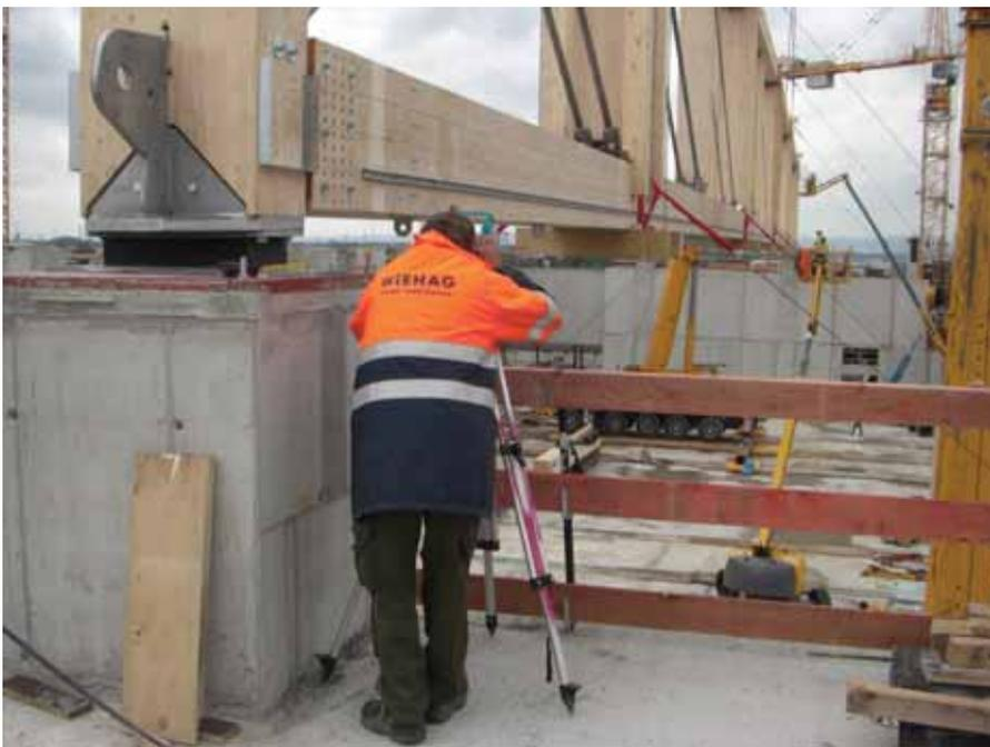
Abb. 2-12: Ausrichten des Binders über die Abspannungen
