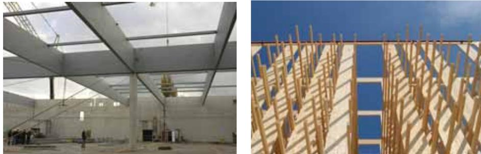
Abb. 5-3: Einsatzbereiche von Brettschichtholz – Hallenbinder und Regalträger
