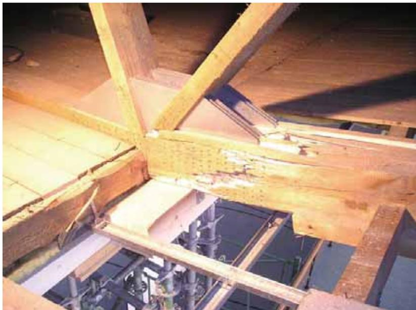
Abb. 3-5: *Bruchstelle des Fachwerkträgers im Untergurt.*
