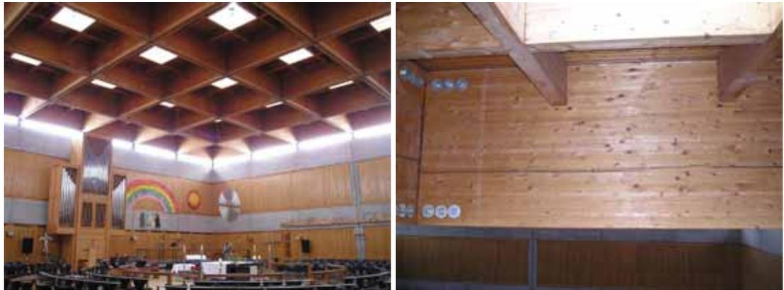
Abb. 3-12: Trägerrost aus paarweise angeordneten Brettschichtträgern über einem quadratischen Kirchenraum (linkes Bild). Die Brettschichtträger sind in den mittleren Feldern auf ganzer Länge durchgerissen (rechtes Bild).
