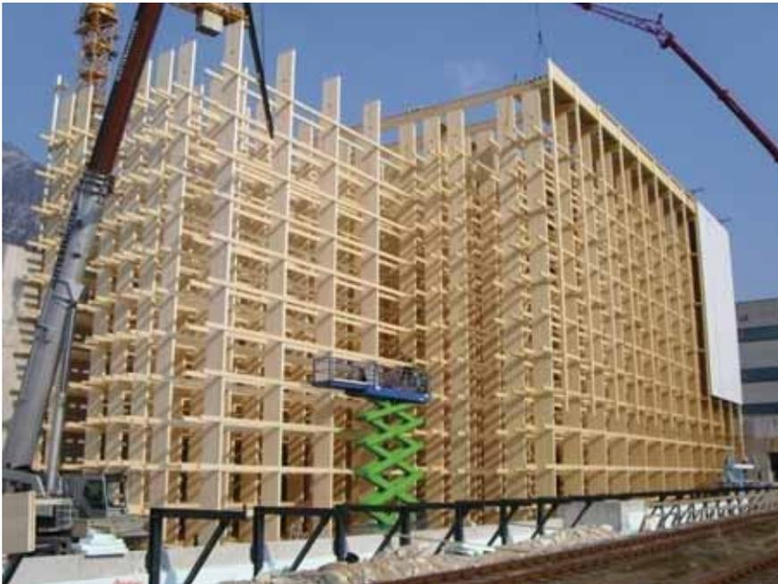
Abb. 1-1: Montage des Hochregallagers der Salinen Austria AG in Ebensee
