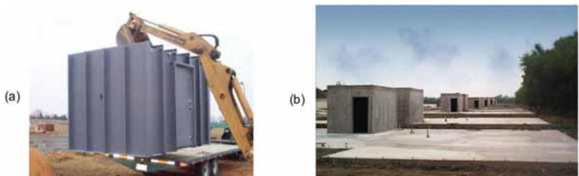
Abb. 11: „In residence tornado shelter“ – traditionelle Stahlbauweise (a) bzw. Stahlbetonbauweise (b) in den USA
