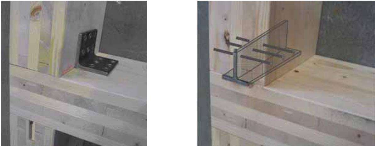
Abb. 2.7: Fügetechnik „Wand-Decke-Wand“ – Schrauben und Stabdübel
