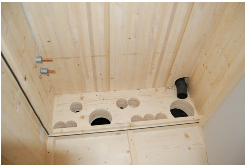
Abb. 3.2: Alles ist perfekt vorbereitet, kein Nachfolgegewerk zerstört bereits Montiertes, das Grundübel auf herkömmlichen Baustellen. Hier können Leckagen fast ausgeschlossen werden. .(Foto: H.Kaufmann)
