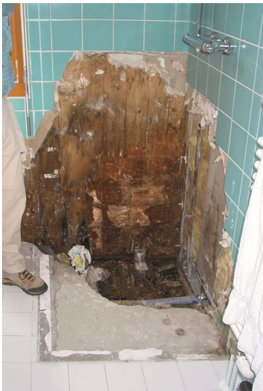
Abb. 3.1: Bad/Duschbereich geöffnet – Wasserschäden an einer Holzkonstruktion (links) Zusammenhang zwischen Druckfestigkeit (rechts unten, [14]) bzw. Biegefestigkeit (rechts oben, [15]) und dem Holzfeuchtegehalt
