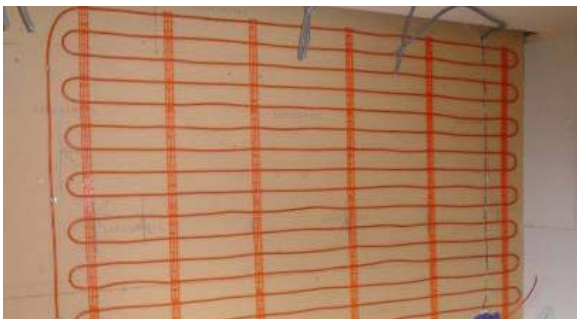
Abb. 2.36: Wandheizung in Lehmputz im Energie Plus Haus Weber Fotonachweis: Arch. Ronacher ZT GmbH
