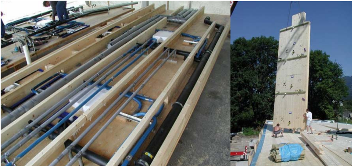
Abb. 3.8: Die gesamten Sanitärinstallationen sowie die Steigstränge der Heizung wurden bereits in der Zimmerei eingebaut und als dreigeschossiges Element montiert. (Foto: H. Kaufmann)
