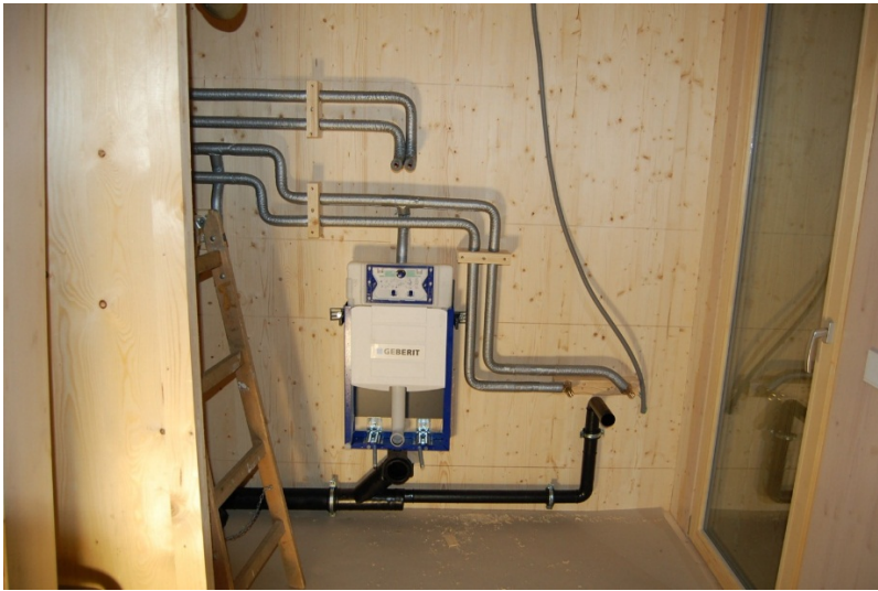
Abb. 3.1: Diese Raumzelle, im Zimmereibetrieb gefertigt, zeigt die hohe Ausführungsqualität der Installationen. .(Foto: H.Kaufmann)
