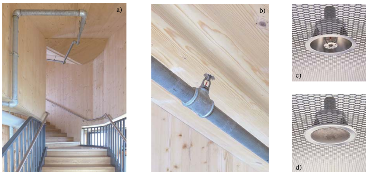
Abb. 3.14: a) und b) sichtbar an der Deckenunterseite installierte Sprinkleranlage c) zurückgesetzter und d) verdeckter Sprinklerkopf [28]
