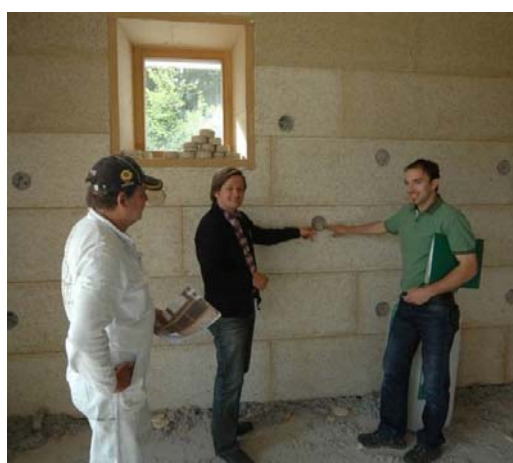
Abb. 4.4: Messsonden im Bereich der Innendämmung, Fotonachweis: Arch. Ronacher ZT GmbH
