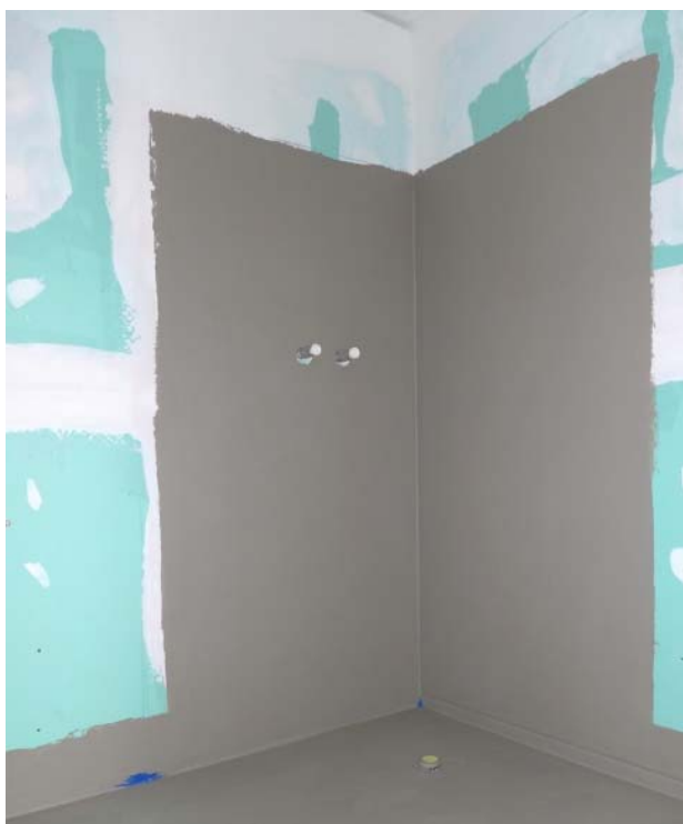
Abb. 3.17: flächiger Dichtanstrich im Duschbereich (links) sowie Dichtband, Dichtband-Innenecke und Dichtmanschette (rechts, [32])
