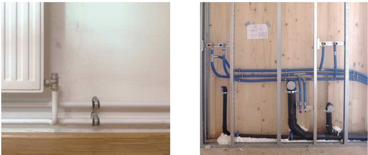
Abb. 3.3: sichtbar (links) und hinter Vorsatzschale (rechts) installierte wasserführende Leitungen
