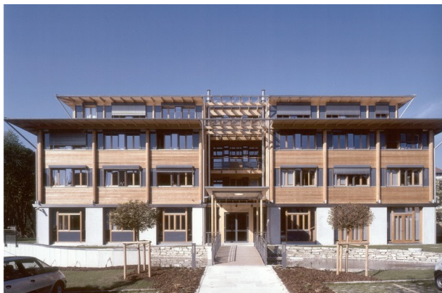
Abb. 2.44: ÖBF-Gebäude, Purkersdorf Massiver Stiegen/Sanitärkern innerhalb des Holzbaus; Fotonachweis: ÖBF AG
