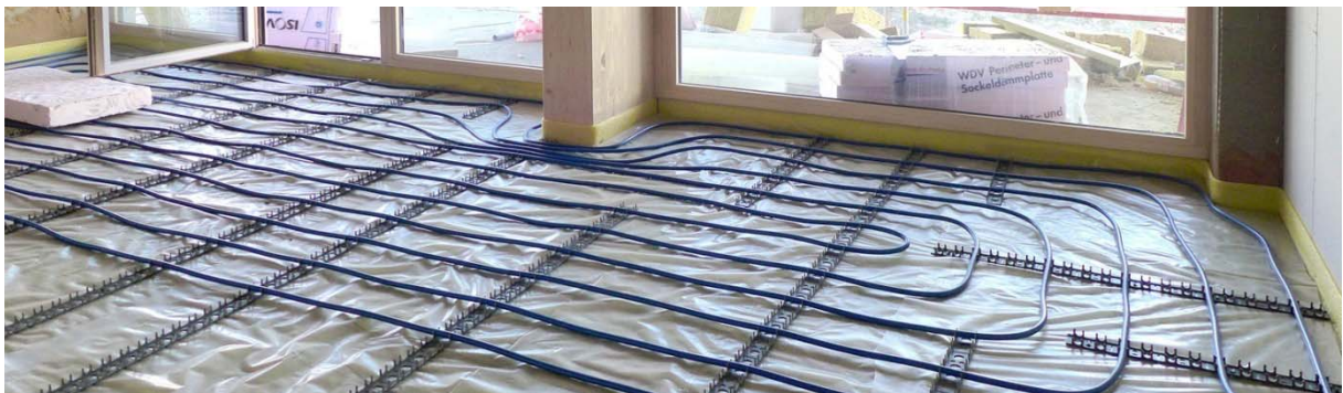
Abb. 3.13: Fußbodenheizung in Wohngebäude in Holz-Massivbauweise
