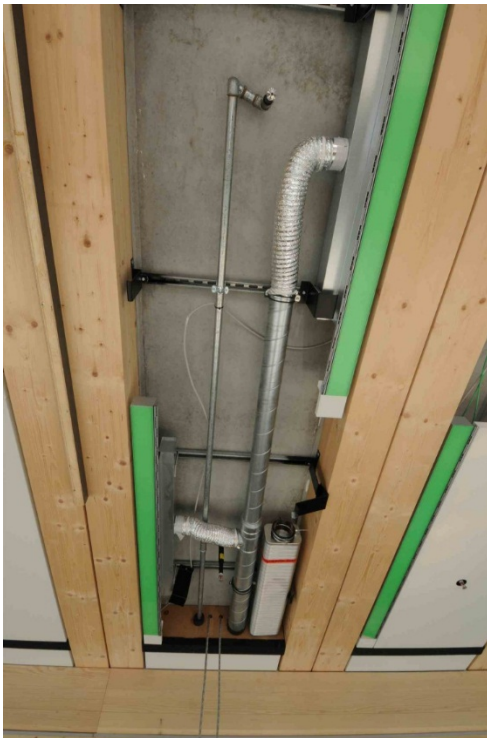
Abb. 3.14: Ausgeführte Variante: Montage in einzelnen Komponenten vor Ort.(Foto: H.Kaufmann)
