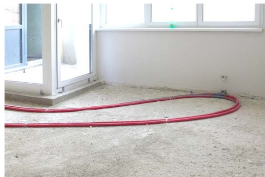
Abb. 3.11: Praxisbeispiele - Leitungsführung auf der Rohdecke in der Fußbodenkonstruktion (blau / Trinkwasser, rot / Heizwasser, schwarz / Abwasser, grau / Strom)
