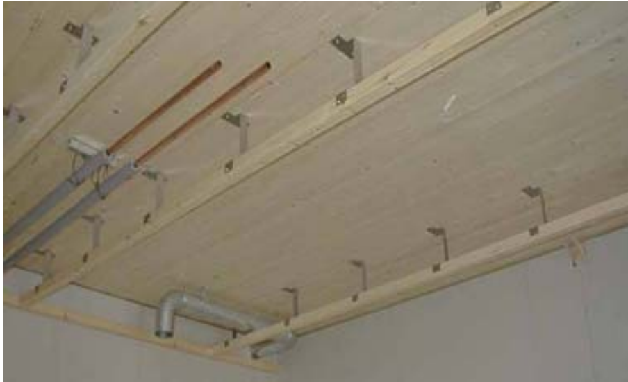
Abb. 3.10: Leitungsführung in der abgehängten Decke
