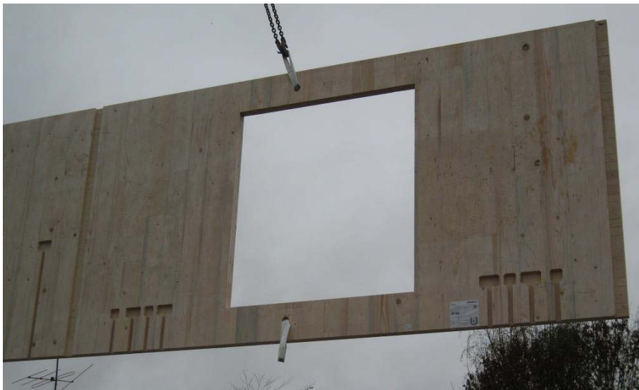
Abb. 3.12: Eingefräste Elektroleitungen
