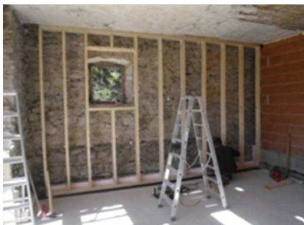
Abb. 4.3: Tragendes Holzgerippe für Dämmung, Heraklith und alte Decke, Fotonachweis: Arch. Ronacher ZT GmbH
