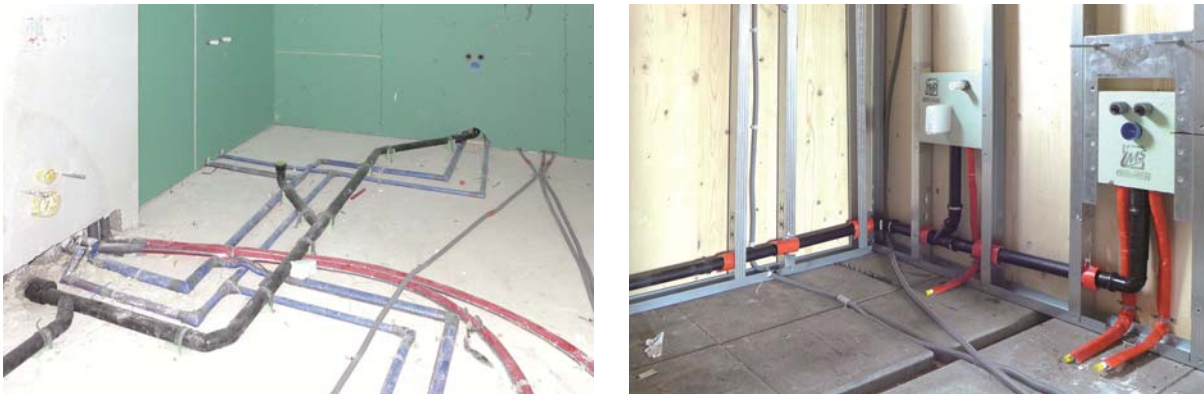
Abb. 3.16: Abwasserleitungen in Fußbodenkonstruktion (links) und hinter Vorsatzschalen (Vorwandinstallation, rechts)
