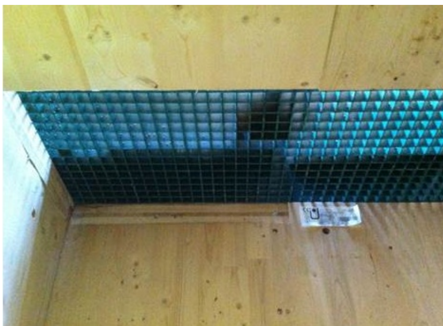
Abb. 3.7: Steigzone mit Sicherheitsrost
