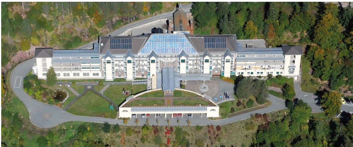
Abb. 2.48: LKH Laas, Kötschach-Mauthen; Gebäude aus dem Jahre 1930 mit Holzbalkendecken wurde 1997 mit neuen Sanitärtürmen ausgestattet (Umgehung der alten Holzdecken und Raumgewinn). Fotonachweis: LKH Laas
