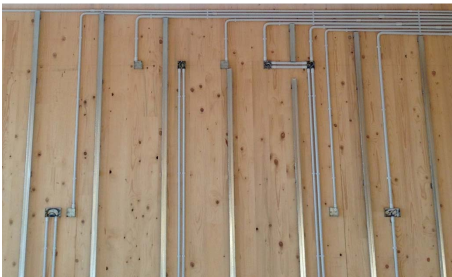
Abb. 3.11: Wandinstallation von Elektroleitungen
