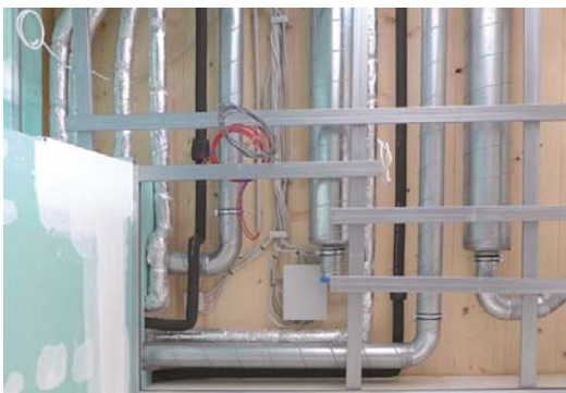
Abb. 3.7: Trink-, Heiz-, Abwasserleitungen sowie Lüftungsrohre in abgehängter Decke (links) Trink- und Heizwasserleitungen in abgehängter Decke (rechts)
