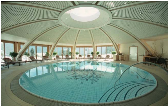
Abb. 2.23: Schwimmbadkuppel im der daberer. das biohotel – St. Daniel Die Zuluftleitungen zur zentralen Kuppel werden zwischen den gebogenen Primärträgern geführt. Fotonachweis: der daberer. das biohotel
