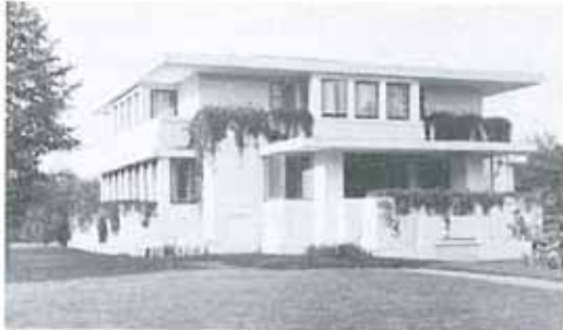
Abb. 86. ROB. VAN T'HOFF: Haus in Huis ter Heide bei Utrecht 1915. (Beton)
