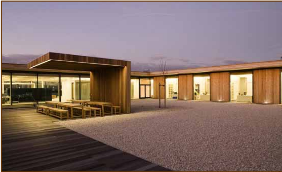
BBS | Woodcenter Kösching, Verwaltung [D]
