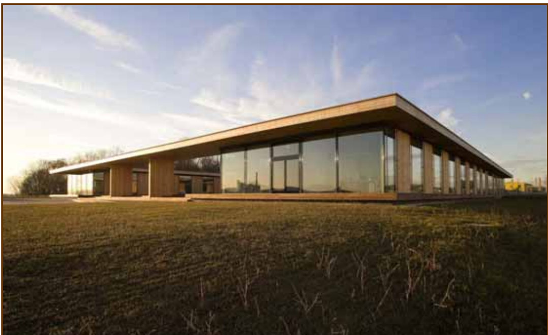
BBS | Woodcenter Kösching, Verwaltung [D]
