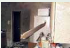
Schadensverursacher 'herumfliegendes Baumaterial'
