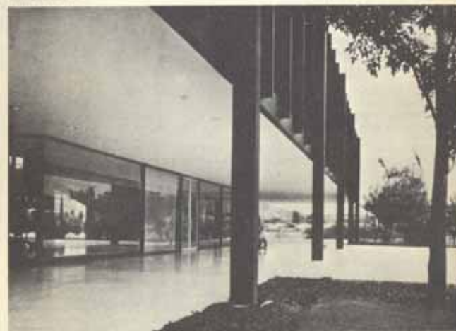
147. Bazaril-Verwaltungshaus, Mexiko, 1961. Die schwebende Beziehung horizontaler Flächen: Boden und Decke sind kreiert, da an einer Stelle vor dem Eingang der Treuenschleife in freiem Strom weit nach außen greift.
