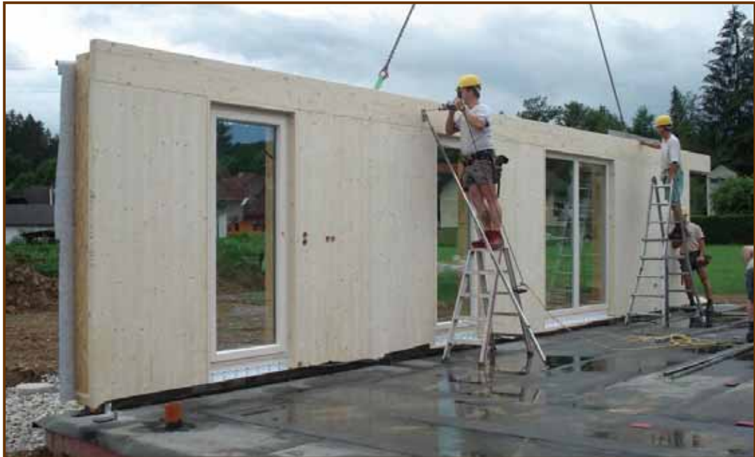
BBS Haus | vorgefertigt durch Holzbaubetrieb
