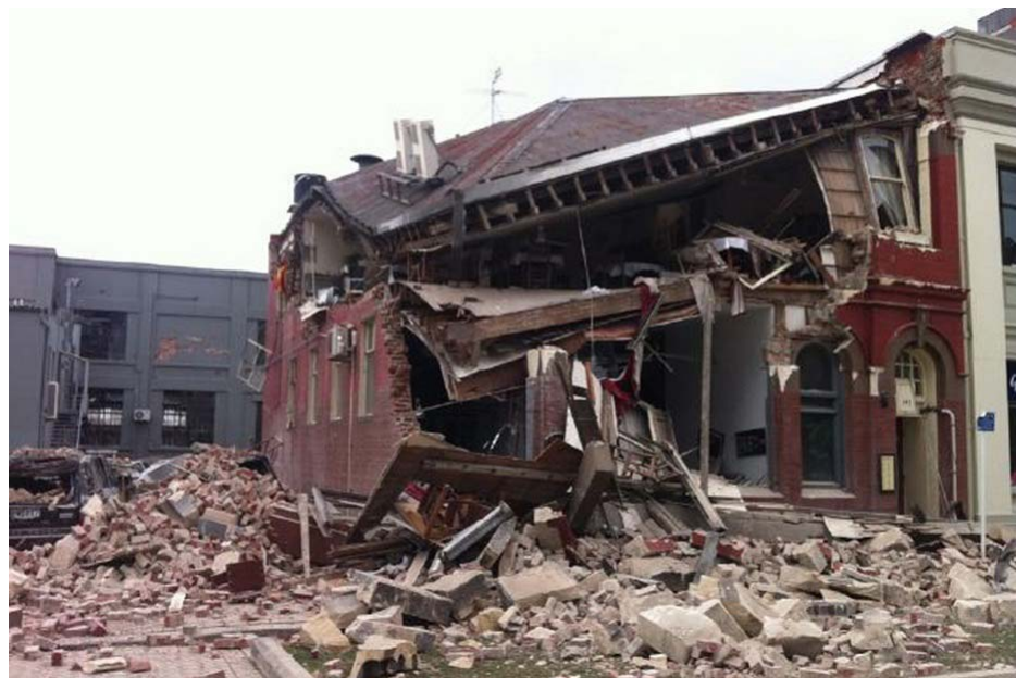
Abb. 1.2 teilweiser Einsturz eines Gebäudes in Ziegel-Massivbauweise mit Holzdecken [39]
