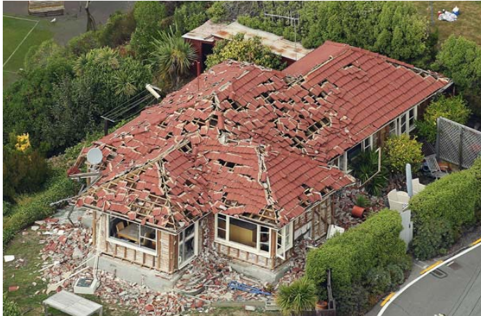
Abb. 1.3 erhebliche Schäden eines Einfamilienhauses in Holz-Leichtbauweise mit Ausfachungsmauwerk und „schwerer“ Dacheindeckung [39]
