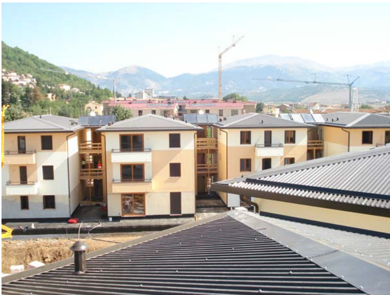
Abb. 1.7 Großaufnahme der fertig gestellten Wohnhäuser in Holz-Massivbauweise [41]
