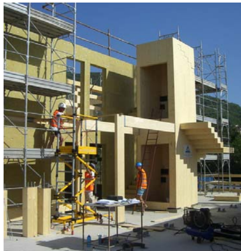
Abb. 1.6 Montage eines Stiegenhauses mit einem Liftkern aus Brettsperrholz [41]
