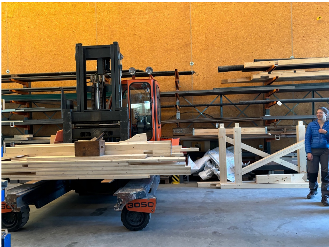
Abbildung 12: Oben: Rückbau der Konstruktion, die geteilten Runddübel werden wiederverwendet. Unten: Der Bausatz trifft in der Inffeldgasse ein.
