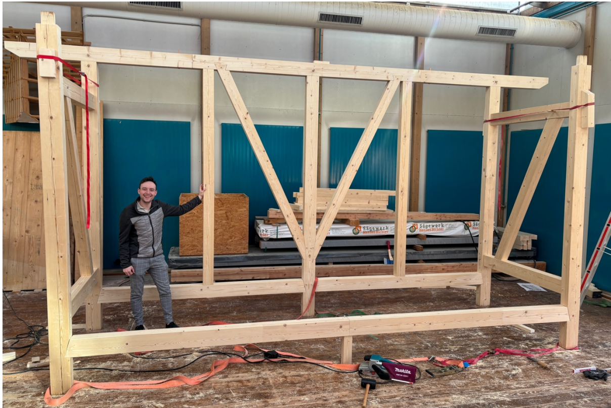
Abbildung 6: Konstruktion ohne Hauptträger: die Fachwerkwand und die verdübelten Verbindungen sind deutlich zu erkennen
