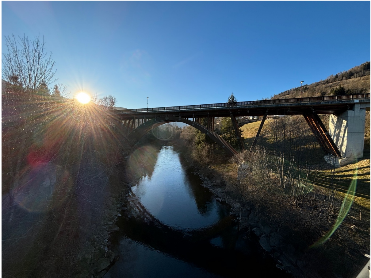
Abbildung 13: Auch eine Besichtigung der Holz-Europabrücke in St. Georgen ob Murau ist ein Pflichttermin des Holzbaupraktikums.
