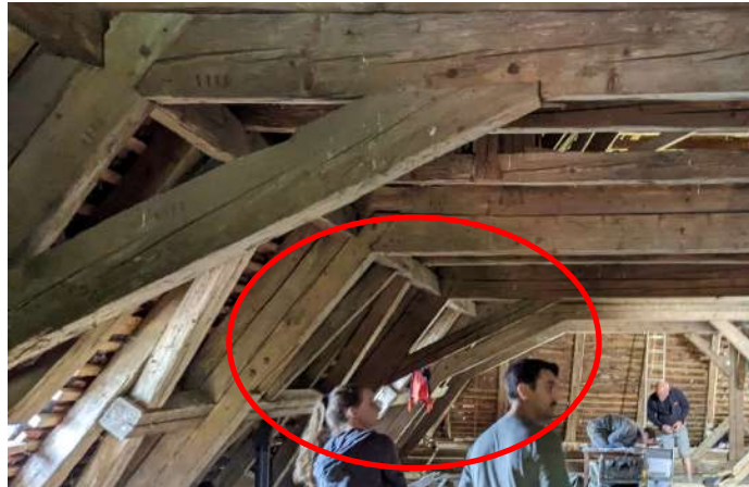
Abbildung 18: fehlendes Kopfband
