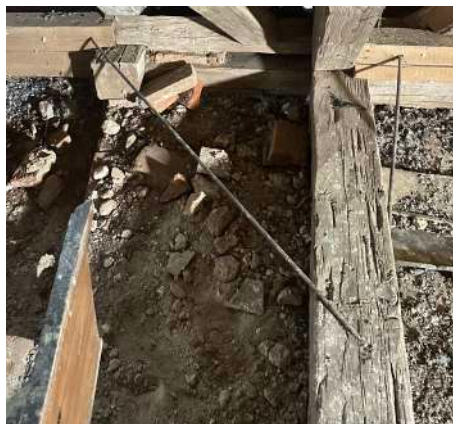
Abbildung 25: Stahlseile von Schwelle zu Bundtram
