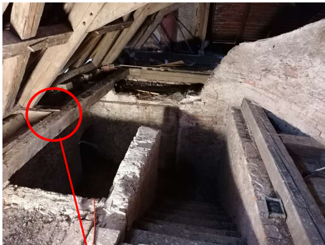
Abbildung 14: Wechselbalken Vollgespärre VII Bereich Stiegenaufgang
