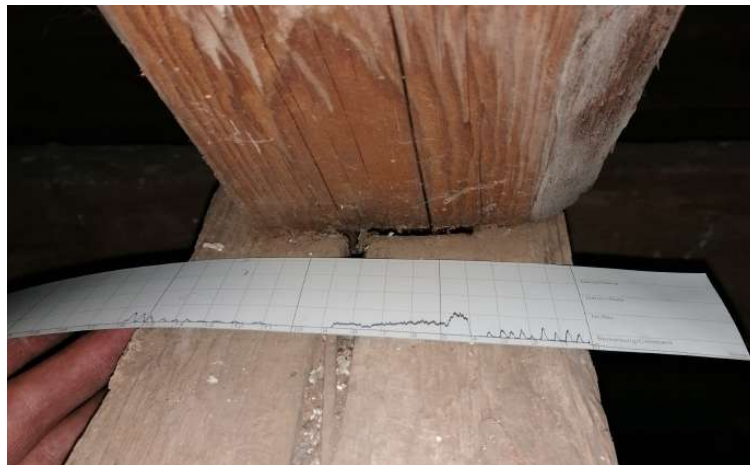
Abbildung 9: Ergebnis einer Bohrwiderstandsmessung
