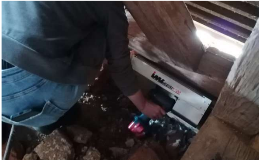
Abbildung 8: Bohrwiderstandsmessung an der Verbindung Stuhlsäule - Bundtram
