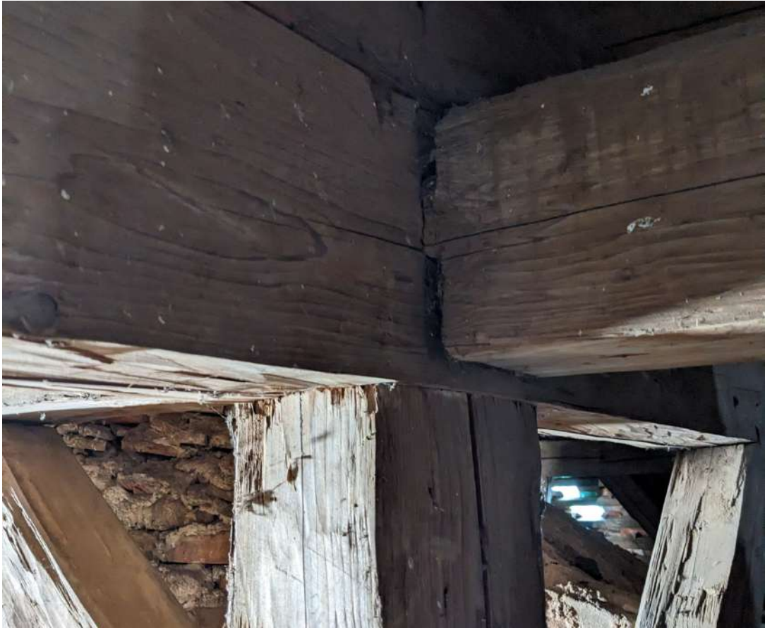
Abbildung 31: Verbindung Stuhlsäule - Spannriegel - Kehlbalken
