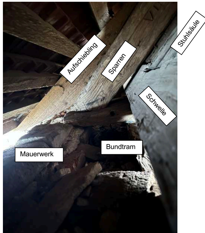
Abbildung 22: Verbindung Sparren, Bundtram, Schwelle und Aufschiebling
