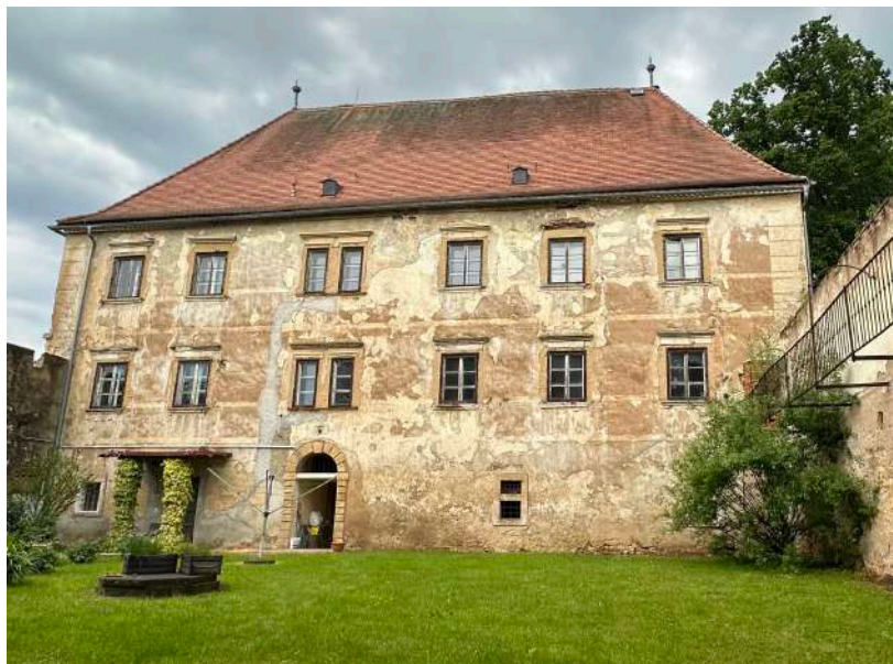
Abbildung 1: Ansicht auf Bauwerk
