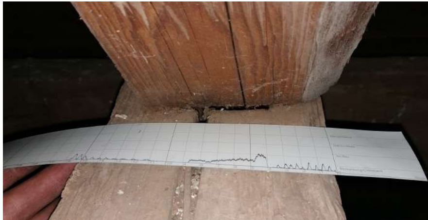
Abbildung 28: Bohrwiderstandsmessung Schräger Zapfen Stuhlsäule – Kehlbalken
