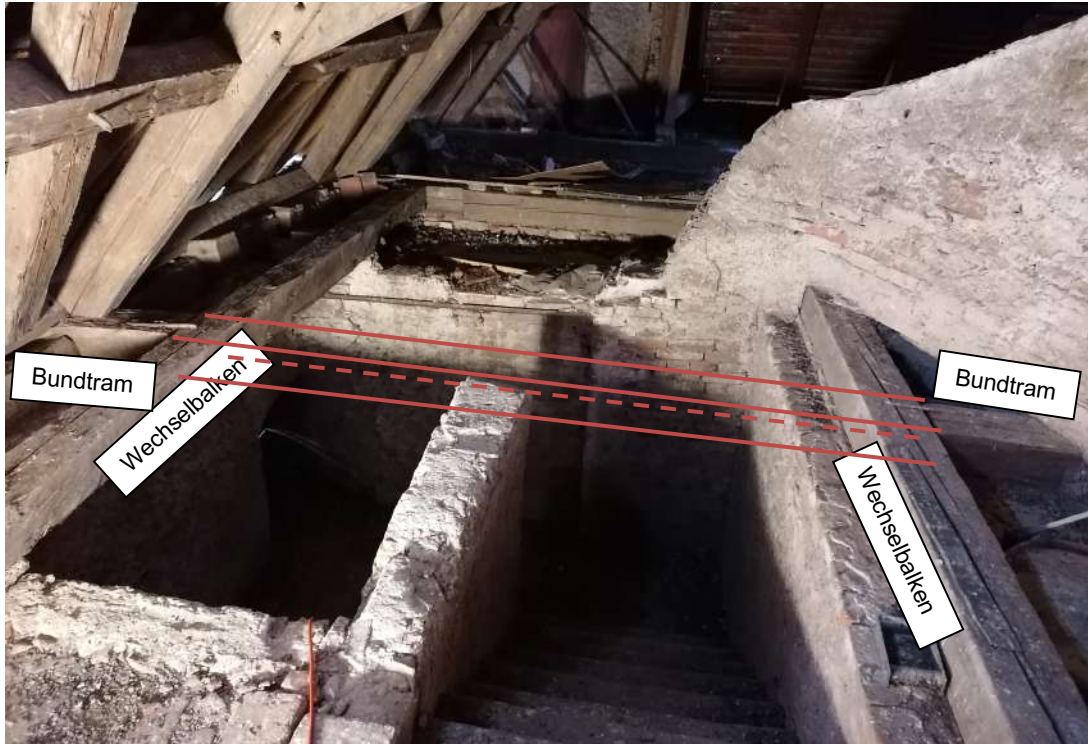
Abbildung 6: Wechsel im Bundtram aufgrund des Stiegenaufganges
