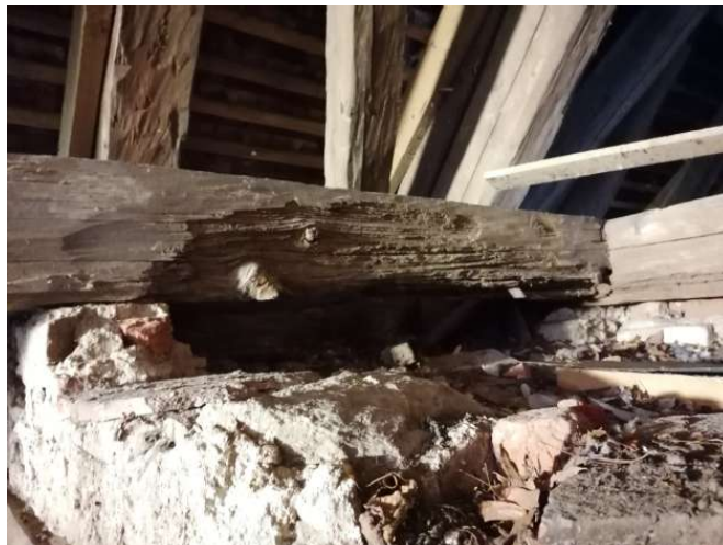
Abbildung 13: Pilzbefall Wechselbalken
