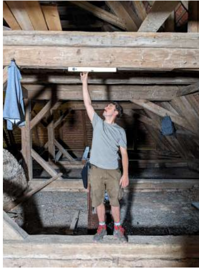
Abbildung 11: geneigter Kehlbalken/Spannriegel
