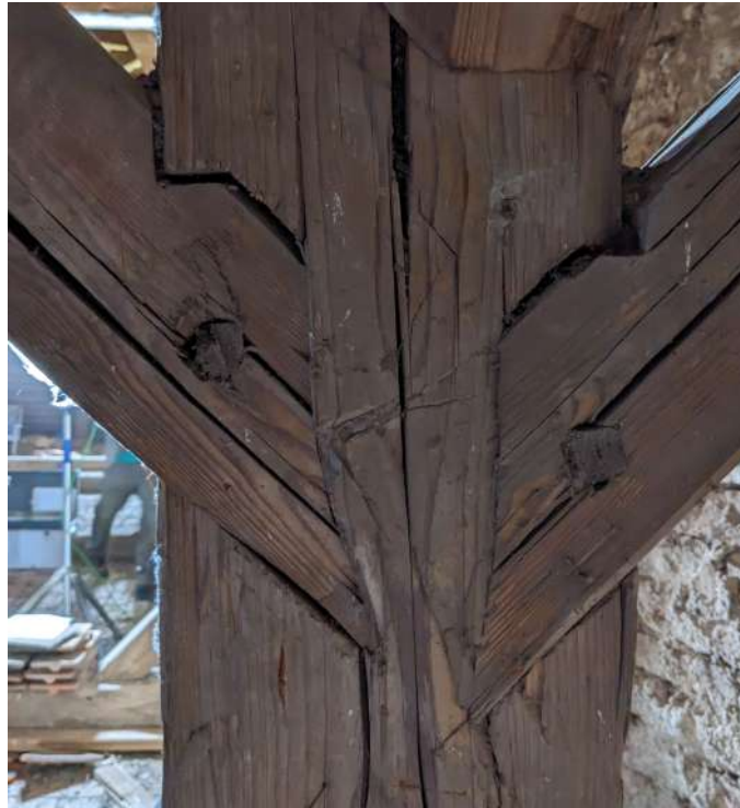
Abbildung 33: Verbindung Stuhlsäule - Kopfband
