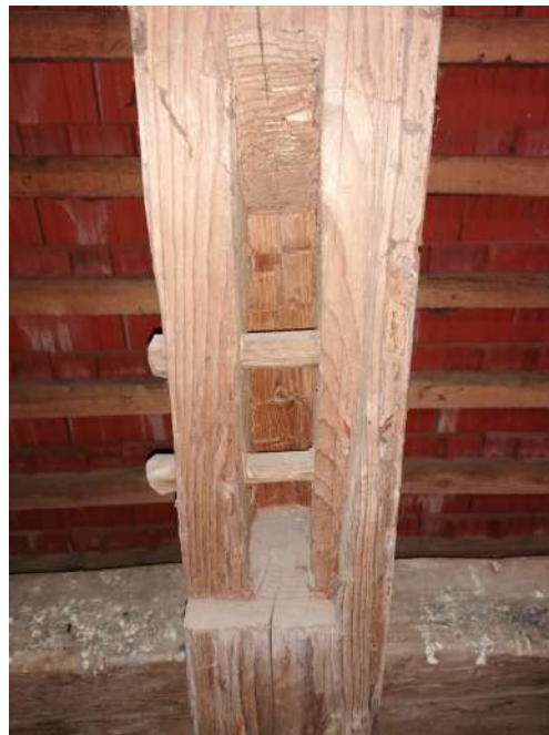
Abbildung 27: Zapfenloch mit Holznägeln, fehlendes Kopfband
