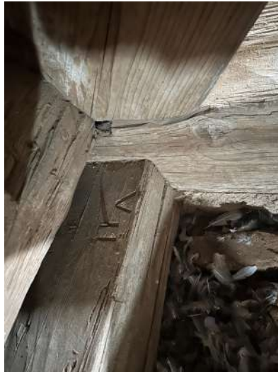
Abbildung 23: Verbindung Stuhlsäule und Bundtram
