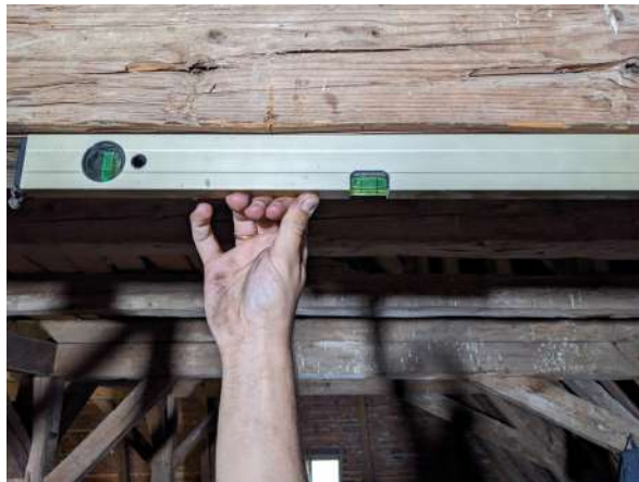
Abbildung 12: Nahaufnahme der Neigung des Kehlbalkens/Spannriegels
