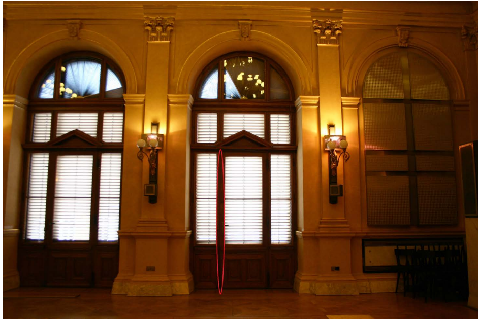
Abbildung 2.15: Störgeräusche durch Verkehrslärm: Einbrüche der Schalldämmung im Bereich der Funktionsfugen der Balkon-Fenstertüren (rot)
