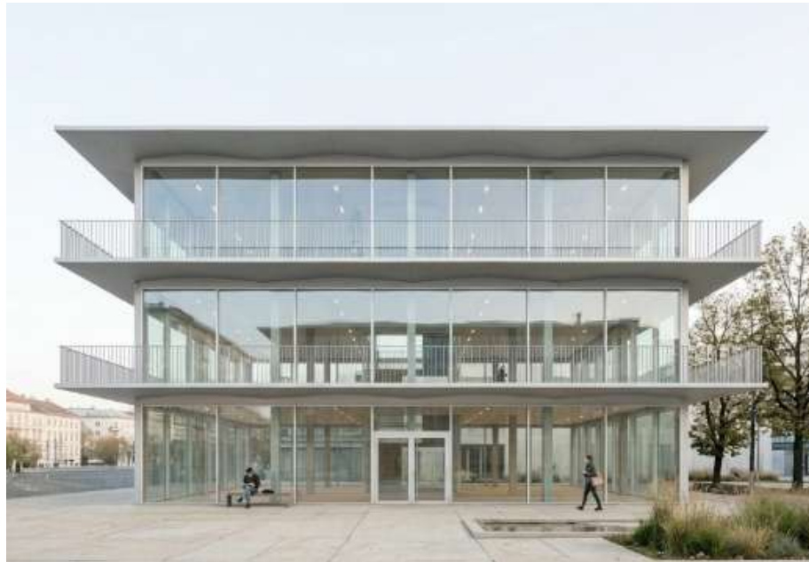
Büro- & Geschäftsgebäude mit doppelt gekrümmter Ortbetondecke (Edges, 2025)
