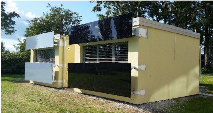
Versuchsgebäude mit autarker Kühlung PV-Anlage
