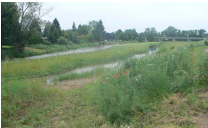
Hochwasserschutz Krems | Flood protection Krems
