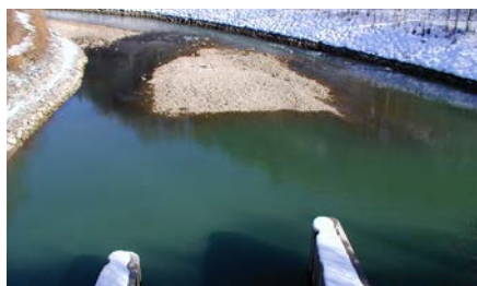
Geschiebeanlandungen unterhalb des KW Wallnerau | Bed load sedimentation downstream of HPP Wallnerau
