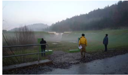
Rückhaltebecken Labuch | Flood retention basin Labuch
