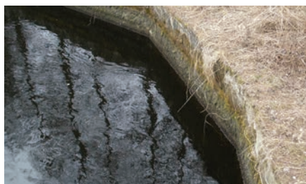
Rückströmbereich Einlauf | Backwater area intake
