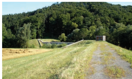
Rückhaltebecken Gamlitzbach | Retention basin Gamlitzbach
