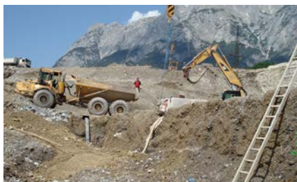
Baustelle KW Pfarrwerfen | Construction site HPP Pfarrwerfen
