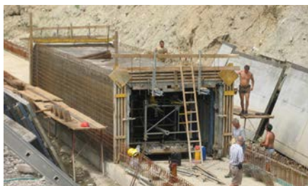
Baustelle | Construction Site
