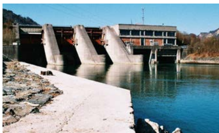
KW Annabrücke | HPP Annabrücke
