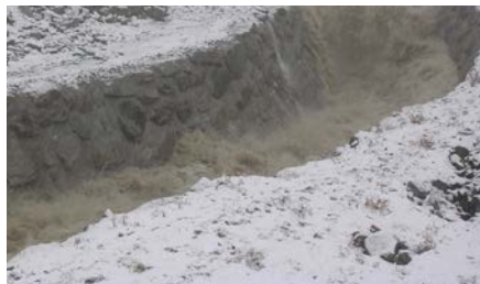
Grundablass Drossensperre | Bootom outlet Drossensperre
