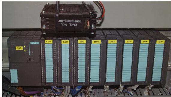
Abbildung 2.26: Aufbau der S7-300 Einheit; Oben:Blockdiagramm, Unten: Einbauzustand
