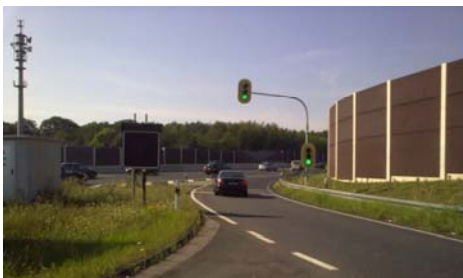
Zuflussdosierung auf Autobahn A40 (Nordrhein-Westfalen, D)
