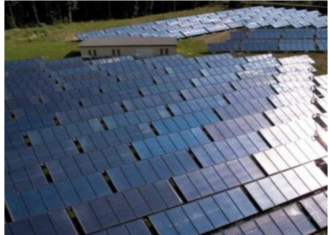
Abbildung 1: Realanlage an der die Prognosemethode getestet werden soll
