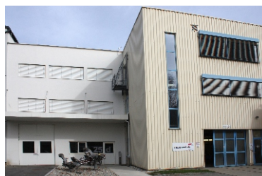
Schwingprüfhalle Inffeldgasse 25/D 8010 Graz
