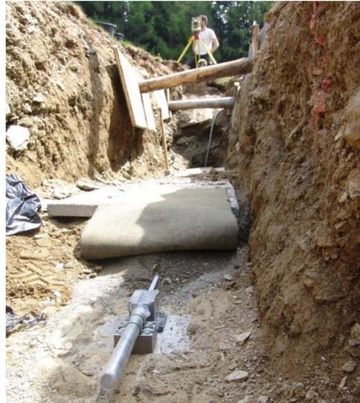
**Abb. 10:** Faseroptischer Sensor beim Einbau
