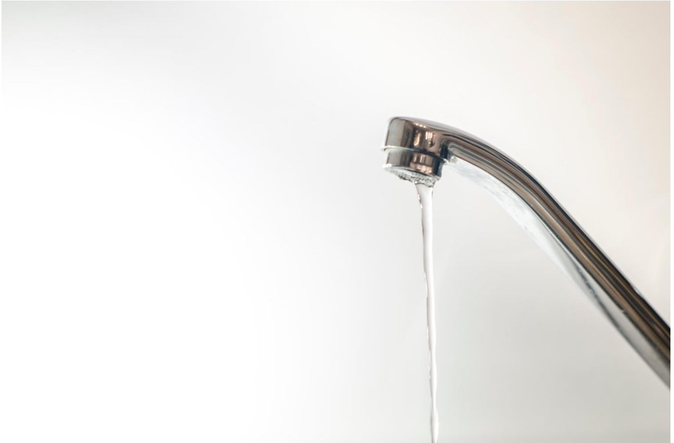
Abbildung 305: Wasserstrahl aus aufgedrehtem Wasserhahn
