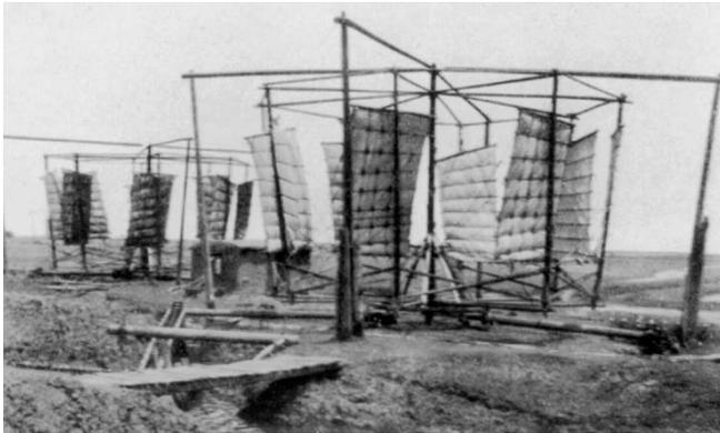
**Abb. 42: Windmühle zum Entwässern der Reisfelder aus China (Hau, 2008, S. 3)**
