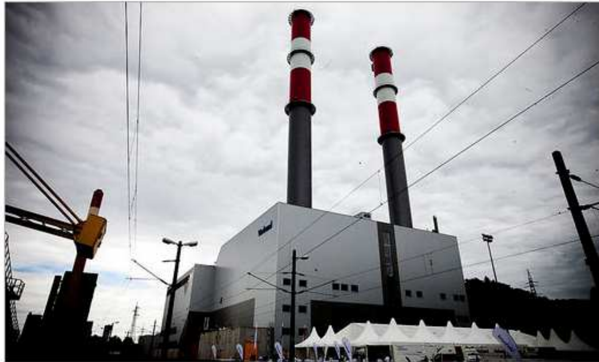
Verbund-Kraftwerk in Mellach
