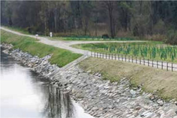
Im Ober- und Unterwasser der Wehranlage werden speziell gestaltete Bereiche als Ein- bzw. Ausstiegsmöglichkeit für wassergebundene Sportarten wie Paddeln, Bootfahren etc. angelegt.
