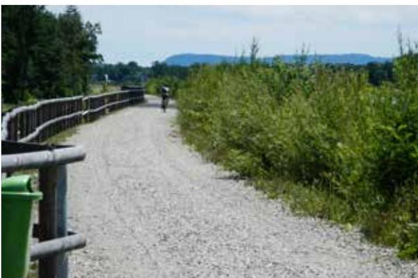
Die Radwegverbreiterung im Bereich der Begleitdämme (befestigte Breite = 3,0 m) führt zu mehr Sicherheit auf den stark befahrenen Murradwegen.
