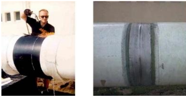
Abbildung 150: Passiver Korrosionsschutz (Chakir & Koch, 2002)
