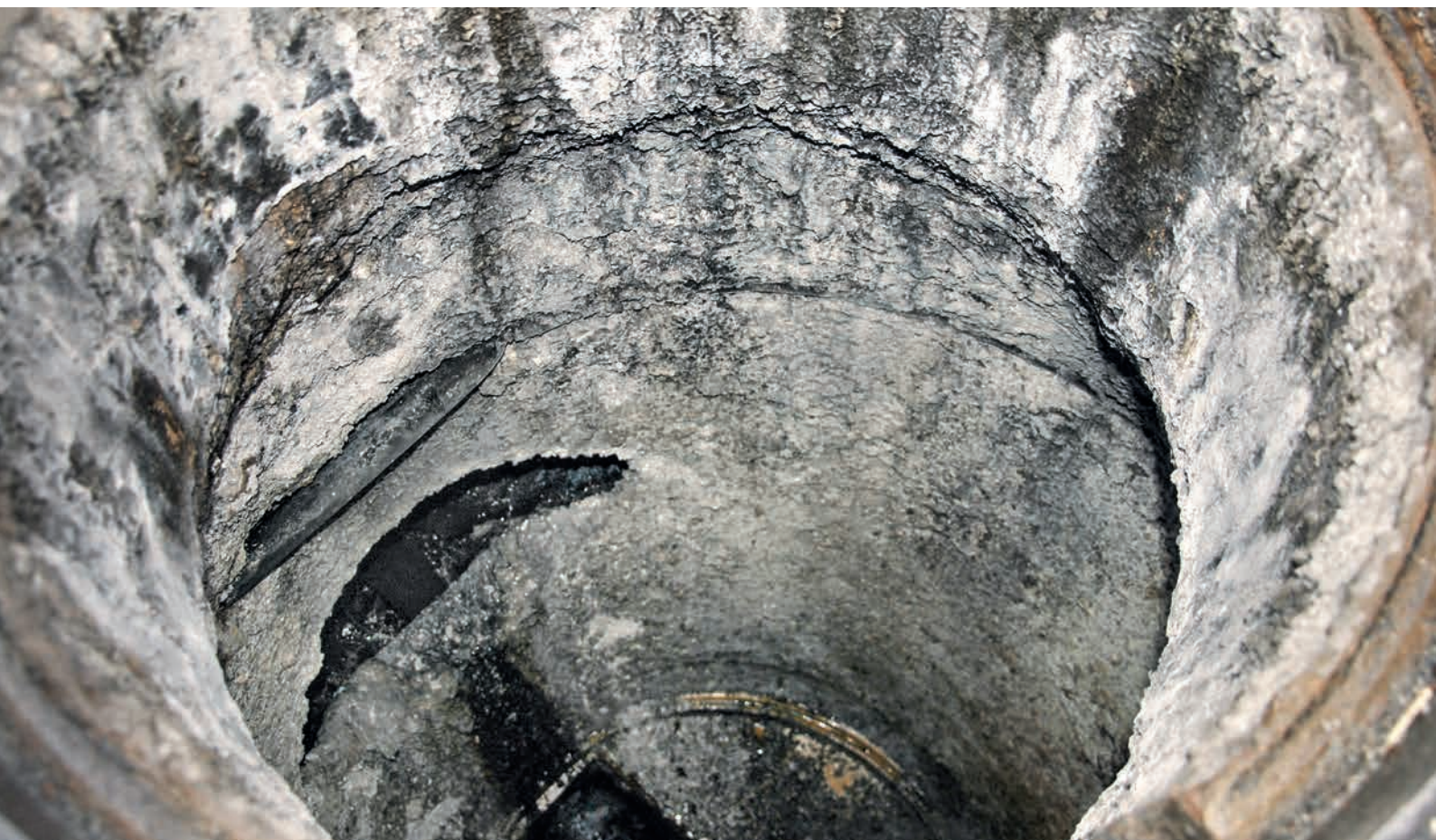
Stark korrodierter Schacht (Alter 10 Jahre) 10 cm Materialverlust
