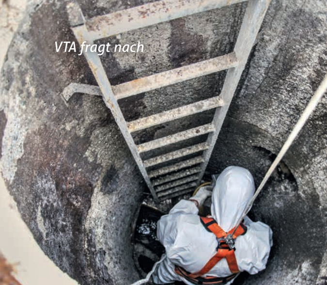
Richtiges Einsteigen in betroffene Schächte
