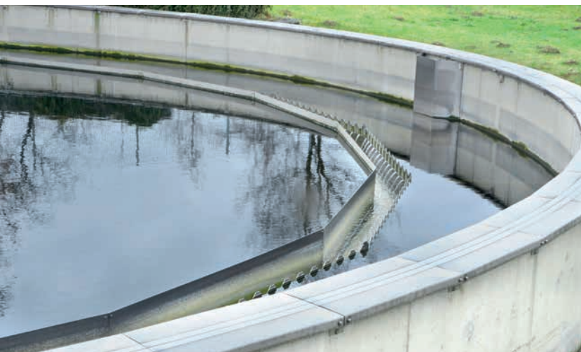
Glasklare Sicht im Nachklärbecken
