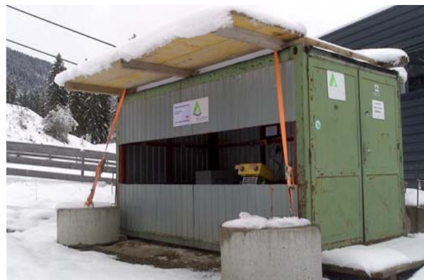
Einsatz des InSAR in Reutte, Tirol zur fernerkundlichen (2,2km) Deformationsmessung einer Felswand.
