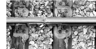
Schotterbettverschleiß an Punkteffekten
