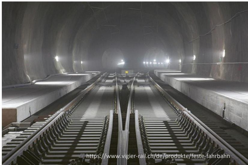
*Die feste Fahrbahn als Zukunftsmodell? Wie funktionieren Weichen auf der festen Fahrbahn und wie performen diese?. Während die Gleislage im Vergleich zu Weichen auf Schottergleisen nicht kritisch ist, sind möglicherweise andere Effekte bei Weichen auf fester Fahrbahn kritisch. Diese Arbeit beschäftigt sich mit dem Qualitätsverhalten dieser Weichen. Für die Bearbeitung wird eine 25-jährige Zeitreihe an ÖBB-Messzugdaten bereitgestellt.*
