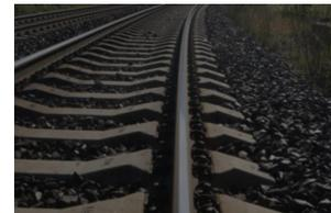
HD-Schwelle als Übergangskonstruktion
