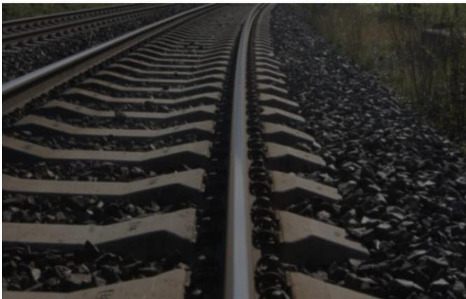
*HD-Schwellen (High duty sleeper) versprechen hohe Lebensdauern und einen instandhaltungsarmen Betrieb. Aufgrund der geringen, vorhandenen Stückzahl und den damit verbundenen hohen Kosten finden sie jedoch kaum Anwendung auf Streckengleisen. Nichtsdestotrotz werden sie an Eisenbahnkreuzungen und Brückenanschlüssen zur Herstellung eines Steifigkeitsübergangs eingesetzt. Ziel der Arbeit ist es, die Performance von HD-Schwellen in diesen Bereichen zu bewerten.*
