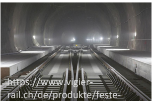
Zustandsbewertung von Weichen auf fester Fahrbahn
