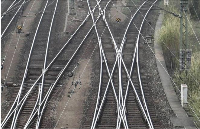
*Kreuzungsweichen ermöglichen sowohl Gleiswechsel als auch Streckenkreuzungen. Aufgrund der vielen (beweglichen) Komponenten stellen einer der komplexesten Anlagen der Eisenbahninfrastruktur dar. Die Zustandsbeschreibung des Fahrwegs ist aktuell nicht möglich. Diese Arbeit soll dies ändern. Für die Bearbeitung wird eine 25-jährige Zeitreihe an ÖBB-Messzugdaten bereitgestellt.*
