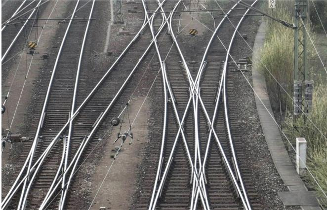
*Schienen des Profils 49E1 wurden und werden auf Strecken der ÖBB eingebaut, bei denen sich die Verkehrsbelastung in Grenzen hält. Die Dauerfestigkeit von Schienen ist u.a. von dieser kumulierten Belastung (Anzahl der Lastwechsel) und der Höhe der Achslast selbst abhängig. Dennoch: dieses Schienenprofil hat in einigen Abschnitten die - angenommene - Grenzbelastung von 280 Mio. Bruttotonnen schon überschritten.*
