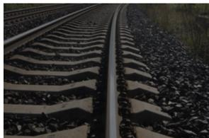
HD-Schwelle als Übergangskonstruktion
