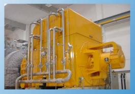
Technische Daten: 19,6 MVA, 10,5 kV, Nenndrehzahl 1.500 1/min (Quelle : ELIN Motoren)
