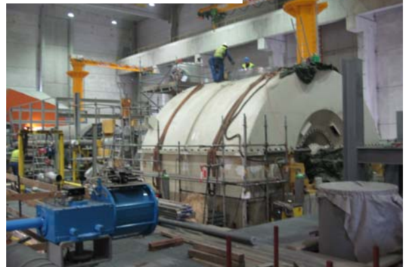
Gas-und-Dampf-Kraftwerk Timelkam, Turbine während Montage
