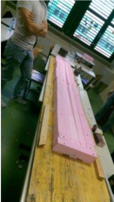
Abbildung 3 Schalung, hergestellt in Abschnitten aus XPS
