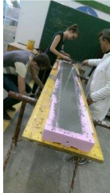
Abbildung 4 Betonieren der Brücke
