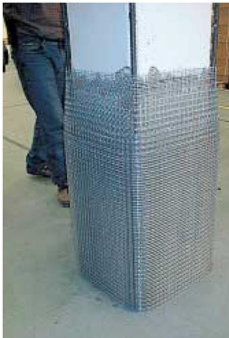
**Bandage:** Zur nachträglichen Verstärkung oder Schadenssanierung von Säulen nach dem System SIMCON wird der Querschnitt mit Stahldrahtmatten umwickelt, die Schalung gestellt und mit selbstverdichtendem Beton (Slurry) verpresst.
