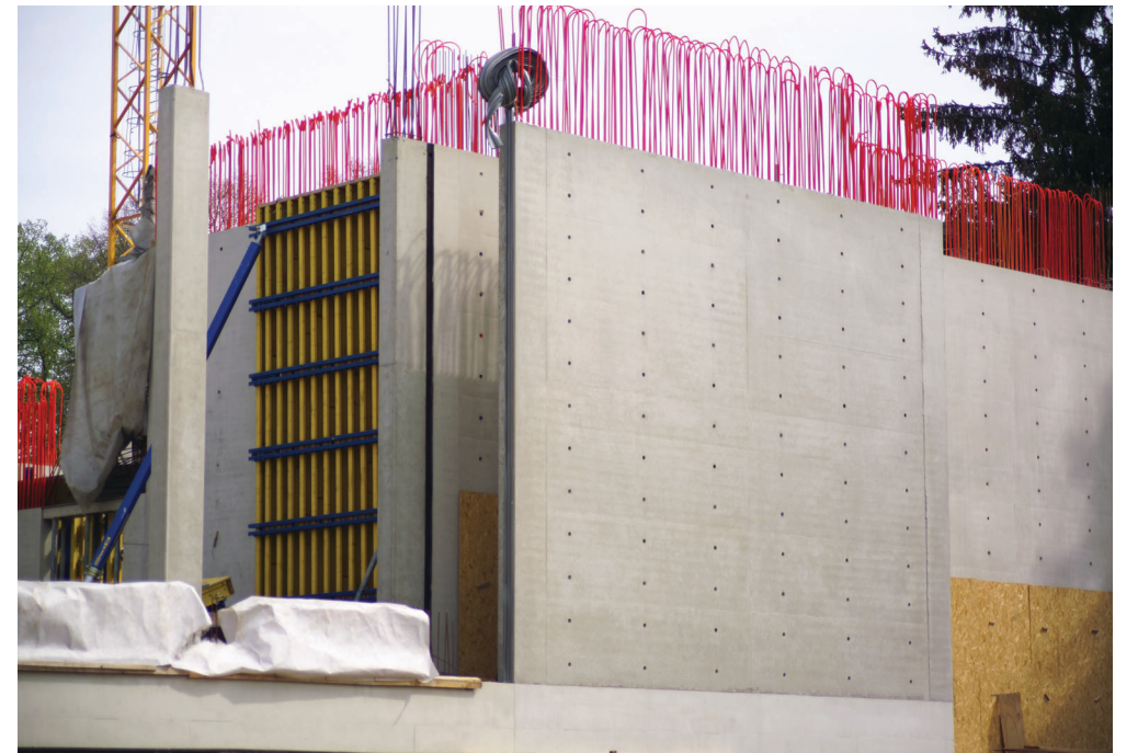
Die Wahl des Schalungssystems hat wesentlichen Einfluss auf die Oberflächenbeschaffenheit von Sichtbetonbauteilen. Das Anker- und Rahmenbild sollte bereits in der Planung berücksichtigt werden.
