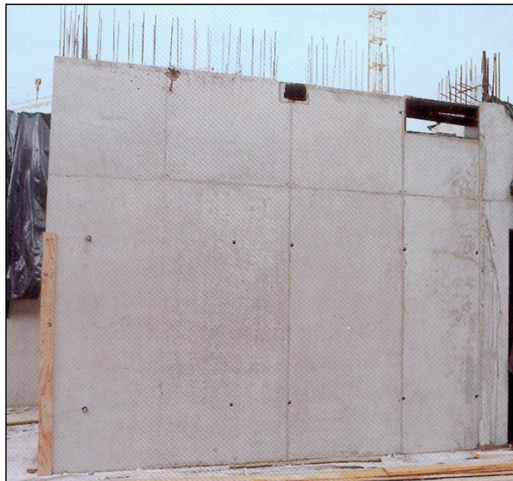
Abb. 5: Wand mit doppelhäufiger Schalung hergestellt – Ansicht (Wirkung)
