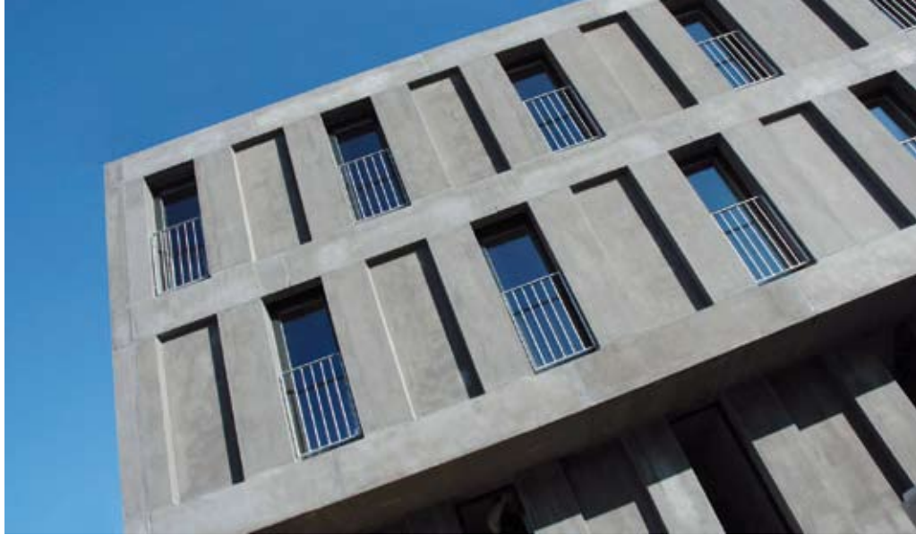
Intensiv: konstruktive, eingefärbte Betonfertigteilelemente bei der Mustersiedlung Hadersdorf
