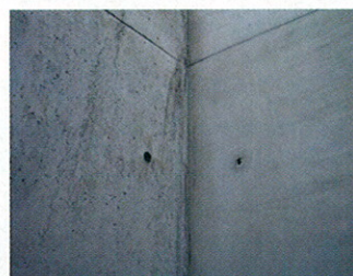
Linker Bildbereich Normalbeton, rechter Bildbereich SVB
