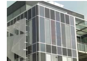
Multifunktionale „Plug&Play“- Fassade [FIBAG/Stallhofen]
