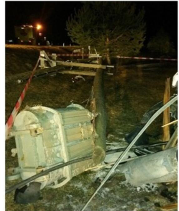
Während der Bergung mit Hilfe von zwei Mobilkränen trat ein Teil des noch in den Kühlrippen verbliebenen Trafoöls aus. Nach der Bergung des Transformators mussten etwa 30 m<sup>3</sup> ölverunreinigtes Erdreich abgegraben werden [www.technik.steiermark.at]
