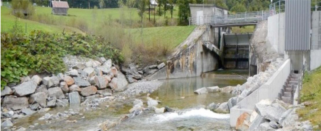
Fassung Furen mit Fischlift: Fotost.: 2; Distanz zur F.: 50 m; Dotierwassermenge: 300 l/s; Abfluss total: ca. 310 l/s
