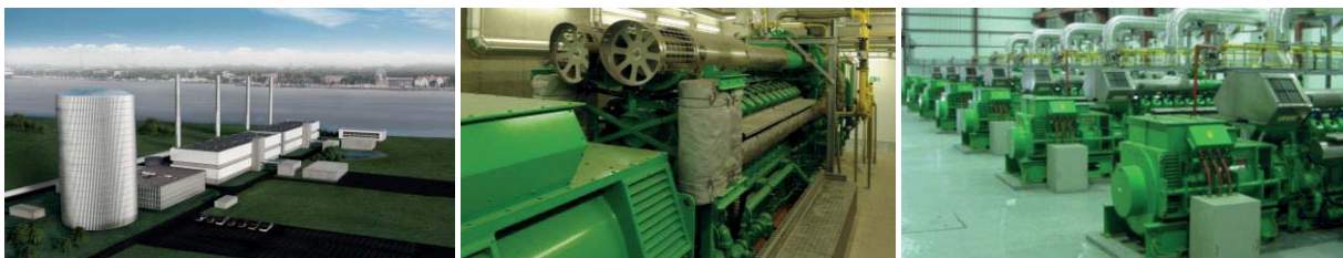
Abbildung 1: Ausgewählte Beispiele mit Gasmotoren: 190-MW-Großmotorenkraftwerk Kiel, 13-MW-BHKW-Anlage in Kirchdorf an der Krems, 80-MW-„rural“-Elektrifizierung in Bangladesch
