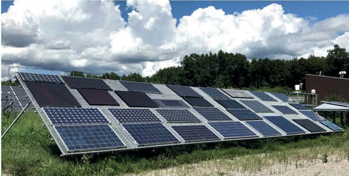
*Abbildung 2: Installierte Modultypen des Hokuto Mega-Solar Systems*
