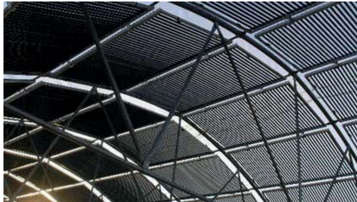
Abbildung 3: Zylindrische Module von Solyndra 13
