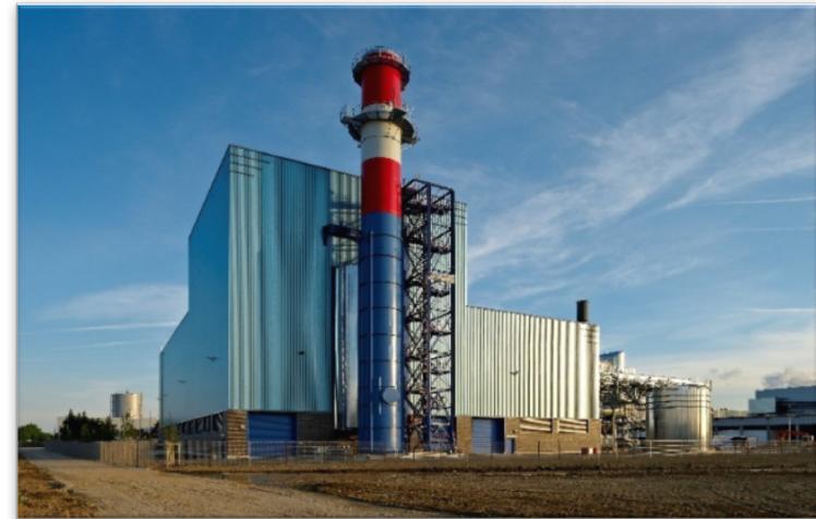
Kraftwerk Plattling (Quelle: E.ON Energy Projects)
