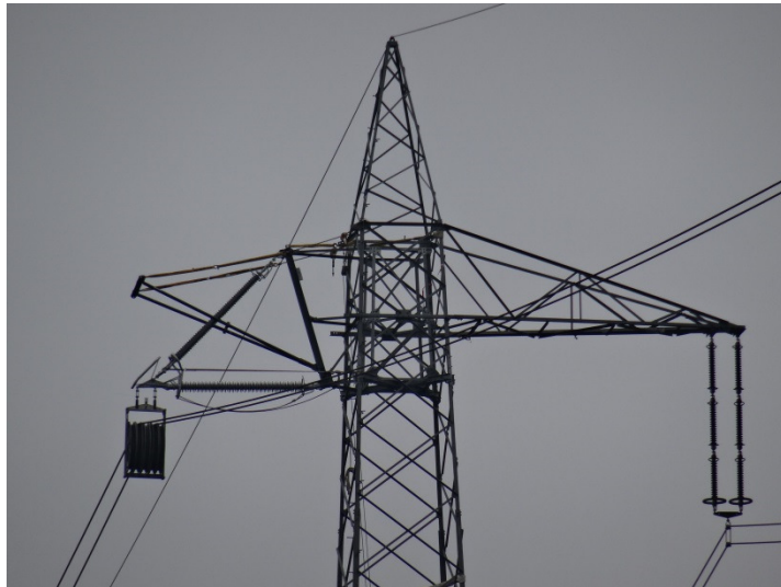
Abbildung 5: Oberer Ausleger während der Umbauphase mit Hebezeug - Vergleich Isoliertraverse / Stahltraverse
