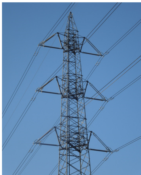
Abbildung 1: 380kV Tragmaste der Innovationssektion nach erfolgreichem Umbau
