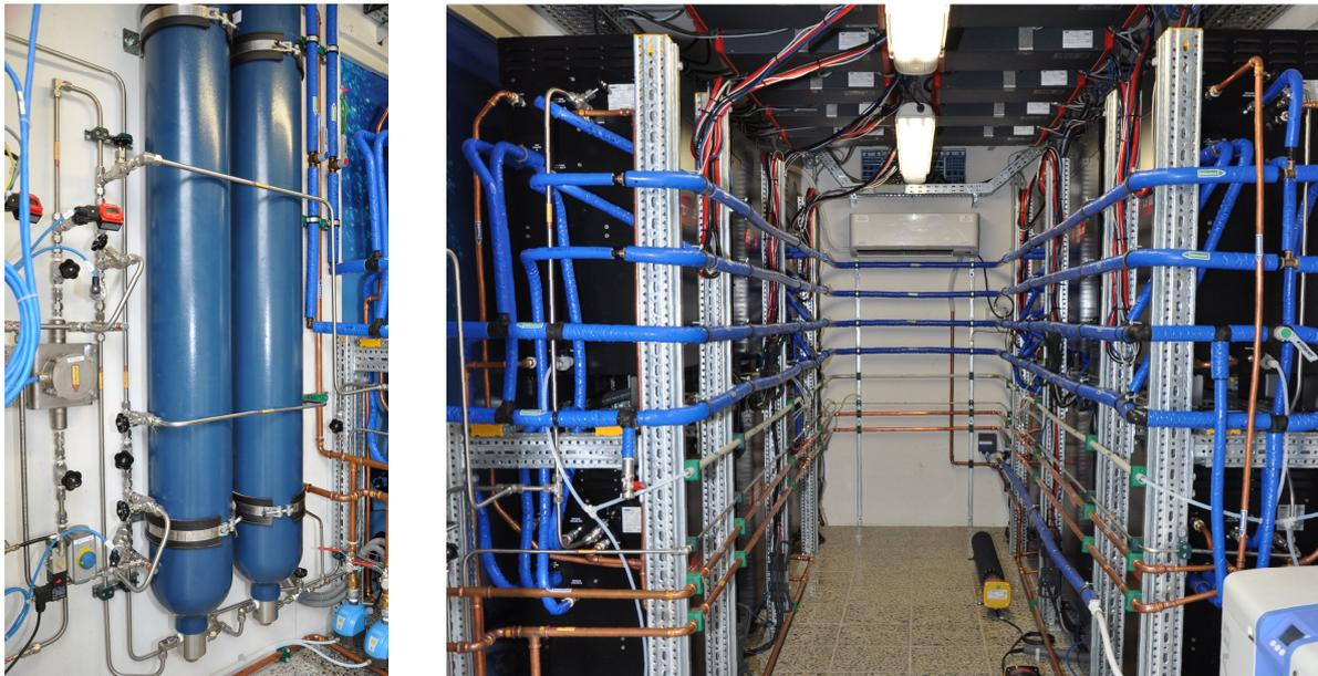
**Abbildung 6: Elektrolyseur: Durchflusssensoren, Taupunktsensoren, Feintrocknung (links); Elektrolysemodule, Wasseraufbereitung (rechts)**
