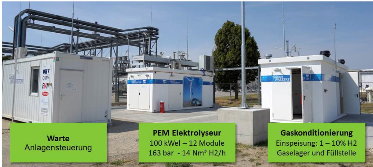
Abbildung 3: wind2hydrogen-Anlage [Quelle: OMV]
