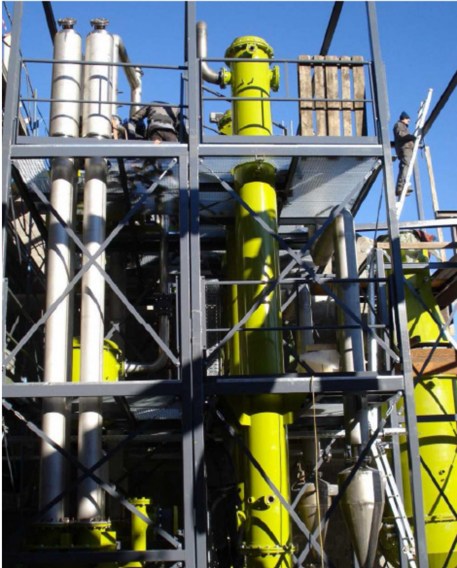
Abb. 3: Ansicht A des Biomasseheizkraftwerkes (Anlage im Bau)
