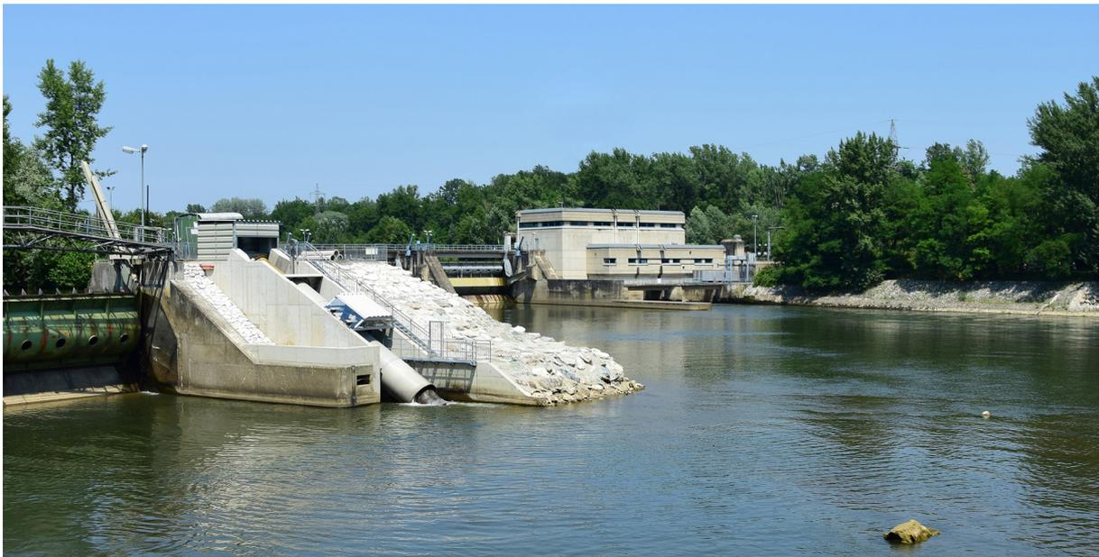
Abbildung 8: Wasserkraftschnecke der Verbund Hydro Power GmbH an der Sulm beim KW Retznei (Wehranlage links im Bild, rechts das Mur-KW Obervogau)
