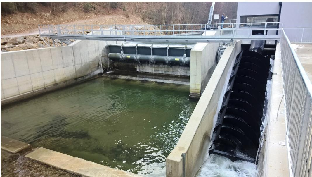
Abbildung 3: Restwasser-Wasserkraftschnecke beim KW Stubenberg / Feistritz
