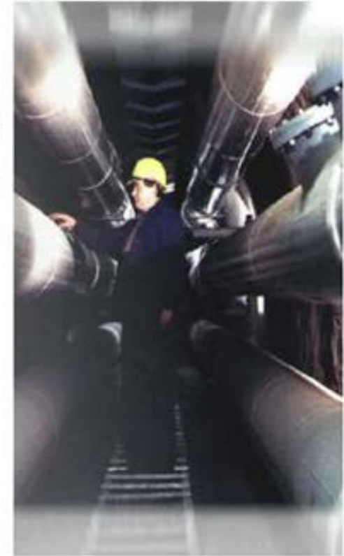
GIL im Kavernenkraftwerk Wehr, Schluchsee, 1974 380 kV, 2000 A, 700 m, 100% SF6
